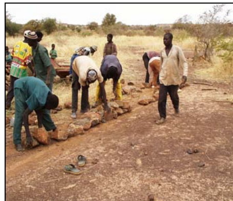
Construction d'une diguette
